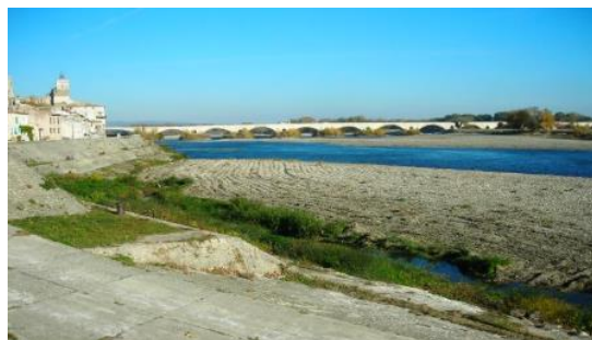
Photo 2 : priorisation des interventions de fauche selon les densités et la fréquentation du public (photo CNR)
