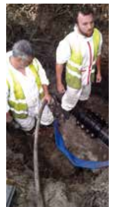
Réparation de la conduite principale pour économiser l'eau.
