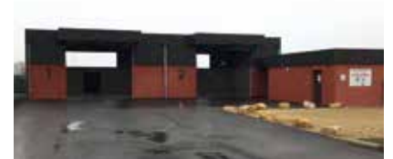
■ L'aire de lavage de Savigny profite à plus de 60 viticulteurs.
