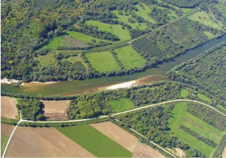
■ À la confluence Doubs-Loue, les enrochements en berges et les digues ont aujourd'hui disparu.
